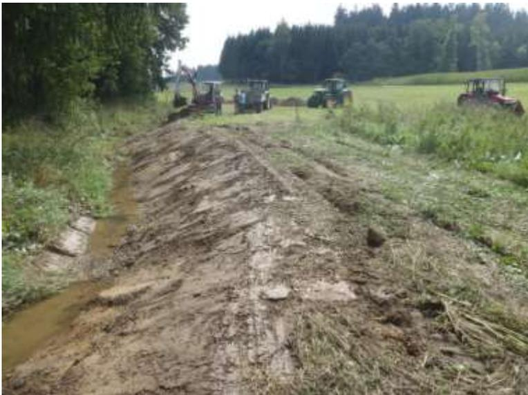
Ausbaggern einer Flutmulde, Abfuhr des Aushubs, Einbau von Steinen in das Bachbett, Einbau von Röhrichtsoden, Vorbereitung der Ansaatflächen, Ausbringen des Saatgutes auf Böschungen des Bachlaufs und der Flutmulde, Einrechen des Saatguts per Hand, Kontrolle des Aufwuchses
