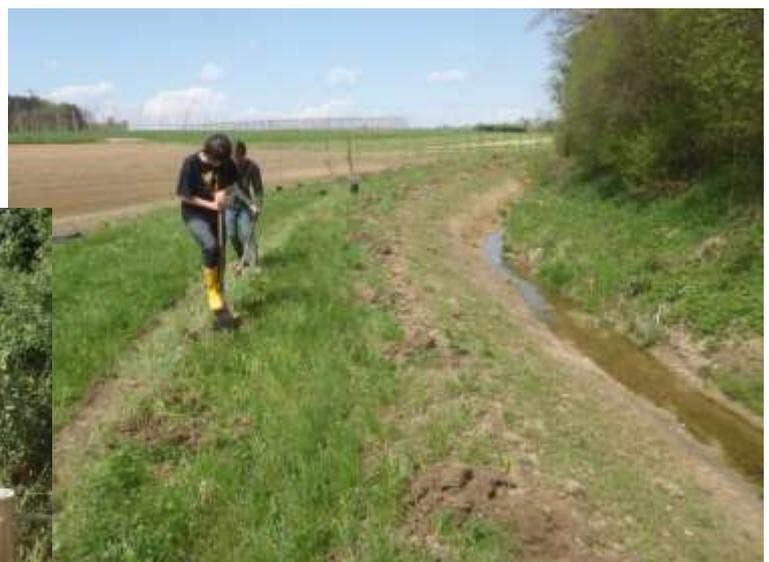
Die abgeflachten Böschungen wurden teilweise mit Röhricht erfolgreich angepflanzt und neu eingesät. Röhricht und Grasaufwuchs schützen jetzt die Ufer vor Erosion.
